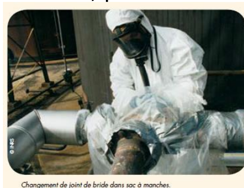
Changement de joint de bride dans sac à manches.
