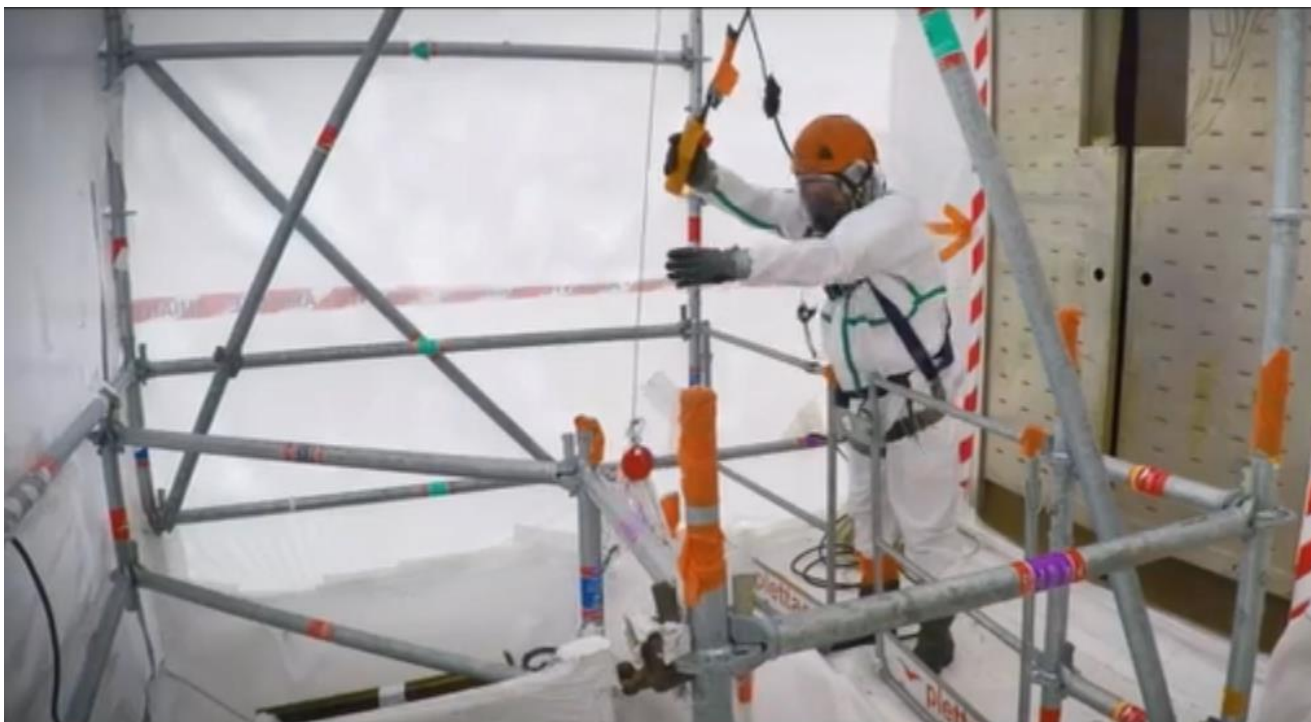
Moyens de manutention des déchets en zone
